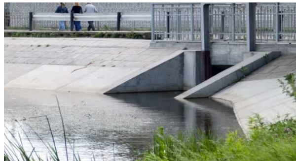
Відремонтвана гідротехнічна споруда (мостовий перехід) біля Теремнівських ставків
